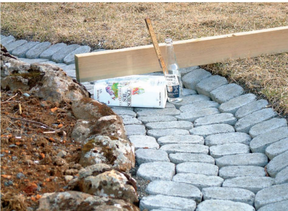
Mynd 16.5. Frostlyfting. Frostfrítt efni, sandur og mól, er undir stéttinni. Frost myndast því ekki undir stéttinni en yfirborð grasflatarinnar lyftist í frostum sökum holklaka og ýtir við stéttinni í jaðrinum. Á sumrin eru stéttin og grasið í sömu hæð.
